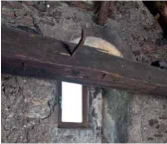
Historischer Holztram vor Mauerwerksnische im Dachgeschoß
