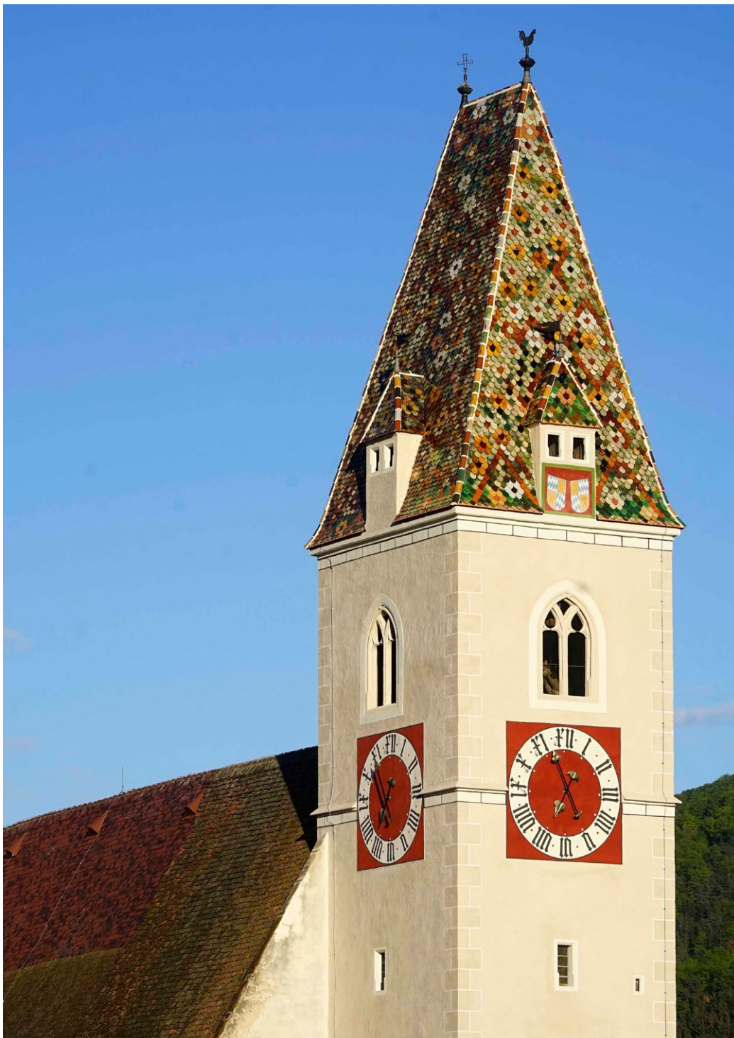
Nach der Restaurierung
