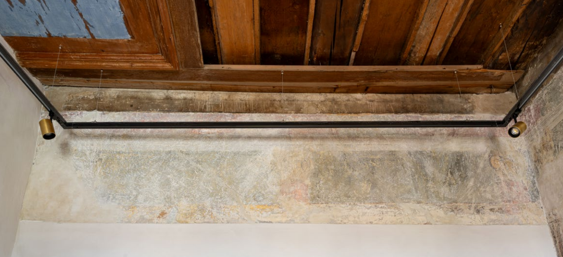
Reste der malerischen Ausstattung an der Nordseite des Saales im dritten Obergeschoß mit Holzkassettendecke.
